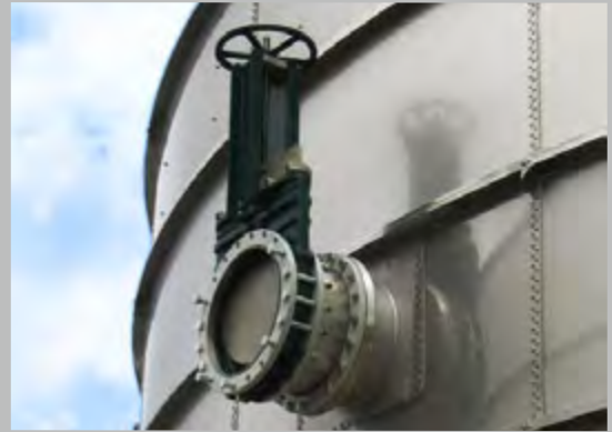
Wanddurchführung mit Schieber Wall bushing with slider
