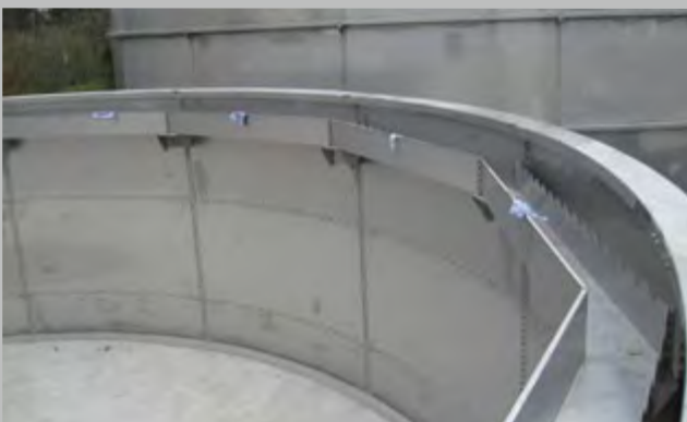
Verzahnte Überlaufrinne Geared overflow gutter
