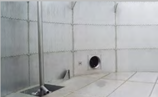
Edelstahlboden mit Ablaufsumpf und Mannloch Stainless steel bottom with flow swamp and manway
