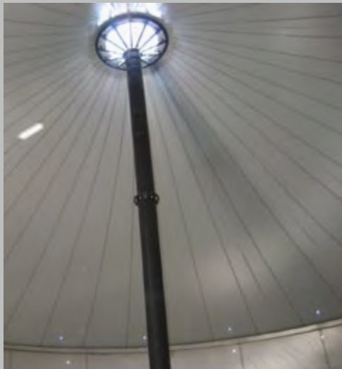
Behälteransicht innen / Mittelstütze Tanks inside / centre support
