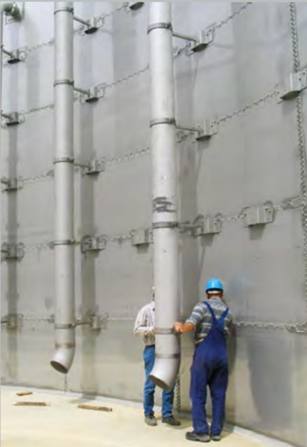
Rohrleitungsbau im Edelstahlbehälter Pipeline construction inside the stainless steel tank
