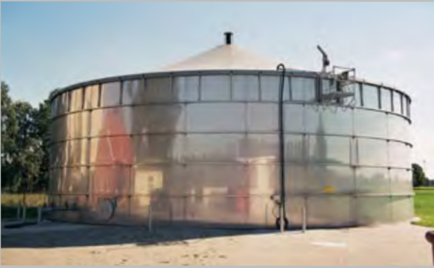
Edelstahl-Güllebehälter mit Foliendach Stainless steel liquid manure tank with foil roof
