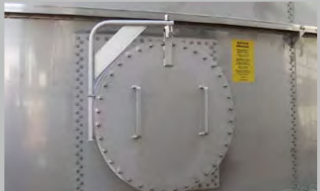
Mannloch DN800 mit Schwenkarm Manway DN800 with rotary arm
