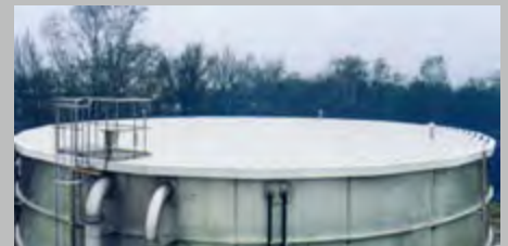
Ausführung Flachdach Achievement flat roof
