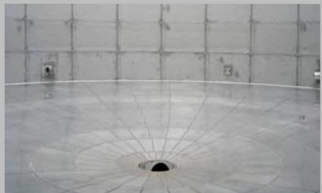
Edelstahlboden mit trichterförmigen Ablauf Stainless steel bottom with funnel-shaped drain outlet
