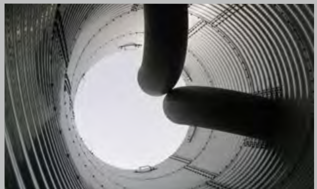
Rohrleitungsbau im Behälter Pipeline construction inside the tank
