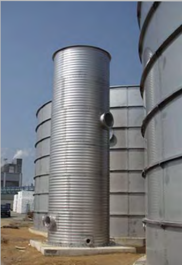
Ausgleichsbehälter Betriebskläranlage Compensation tank in a sewage plant
