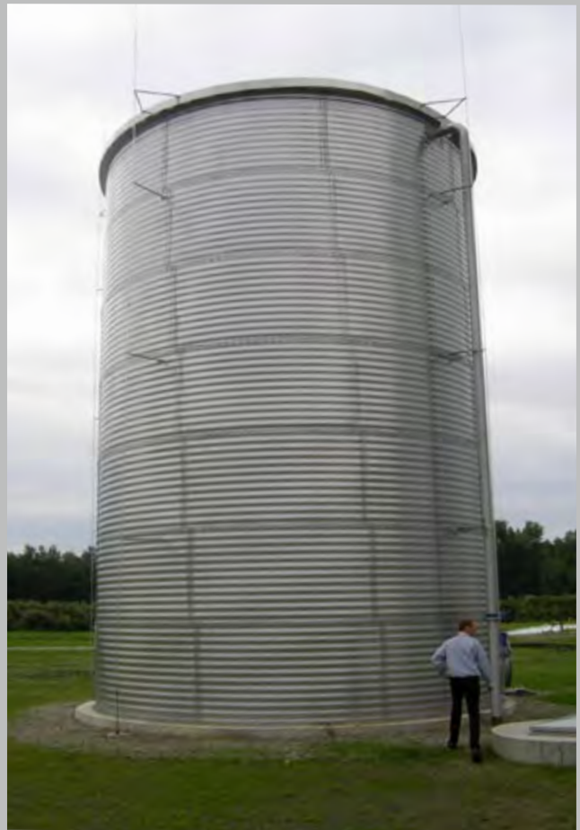
Edelstahlbehälter mit Blitzableitsystem Stainless steel tank with lightning conductor
