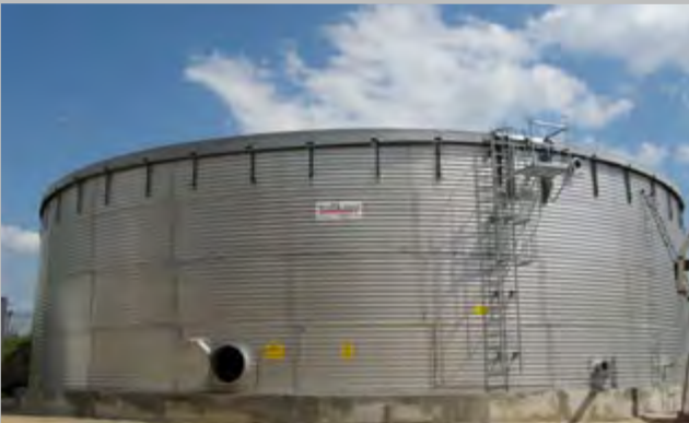
Aufstiegleiter mit Rückenschutz und Arbeitsbühne Ladder with back-protection and working platform
