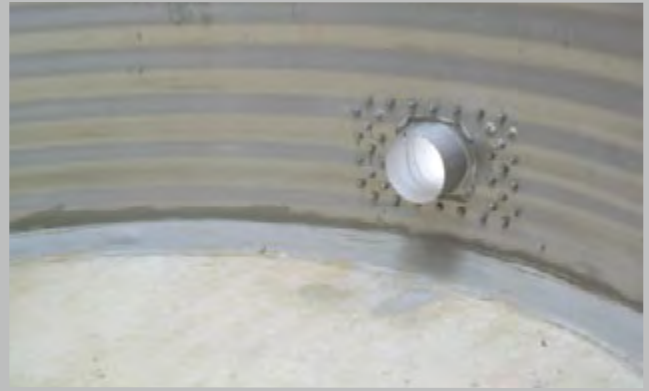
Bodenabdichtung im Behälter Bottom sealing inside the tank
